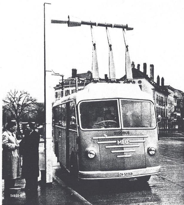
Fig. 7. Le premier Gyrobus en service d'essais à Yverdon en novembre 1950. Station avec mât d'alimentation pour le lancement du volant.
